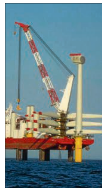
Zwischenlager auf See zum Ablegen der Rotorblätter.
