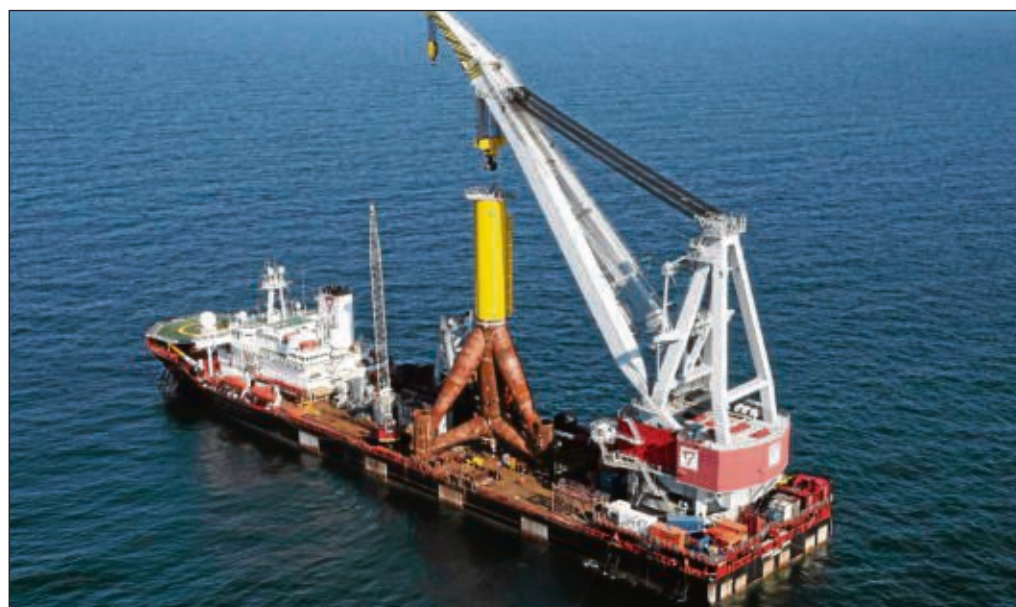
45 Meter hoch ist das Dreibeinige, das vom Transportschiff aus auf den Meeresboden 30 Meter unter der Wasseroberfläche versenkt wird. Die Arbeiter auf dem Schiff sind nur mit der Lupe erkennbar.
